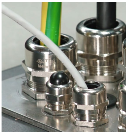
Abbildung 44: Kabelverschraubungen festziehen
