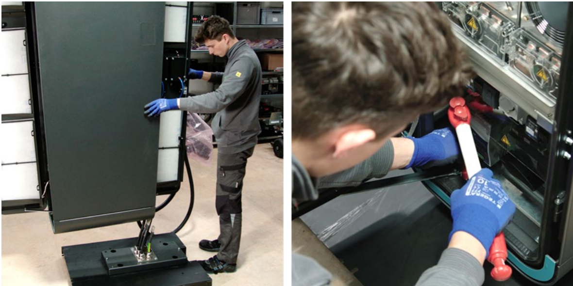
Abbildung 45: Positionierung und Befestigung des HYC400 auf der Basis
