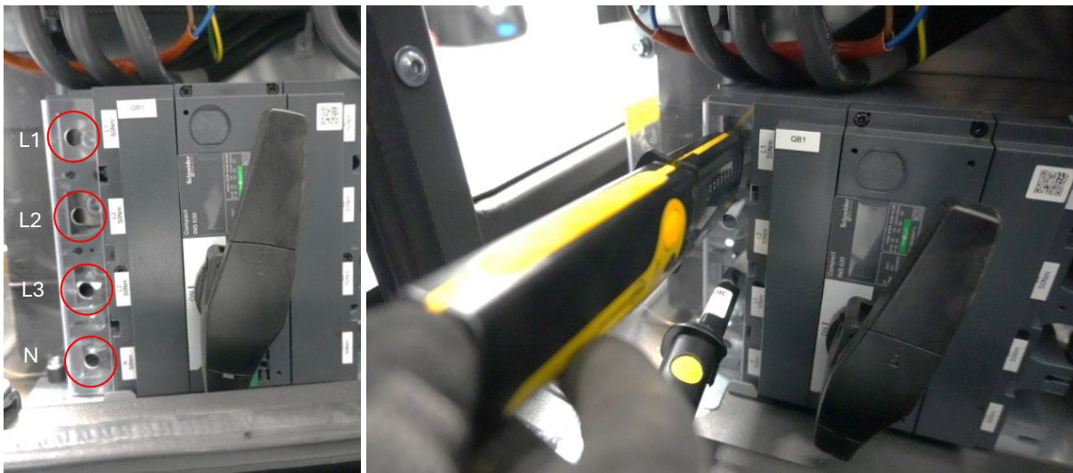
Abbildung 59: Spannungsmessung ausführen
