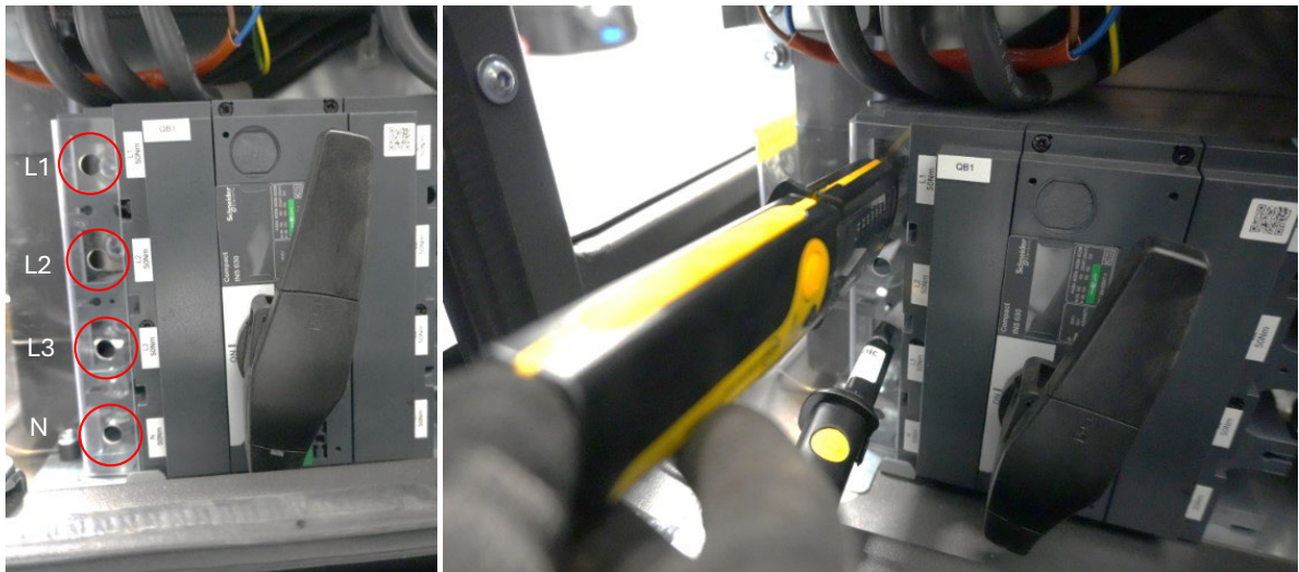
Abbildung 57: Spannungsmessung ausführen
